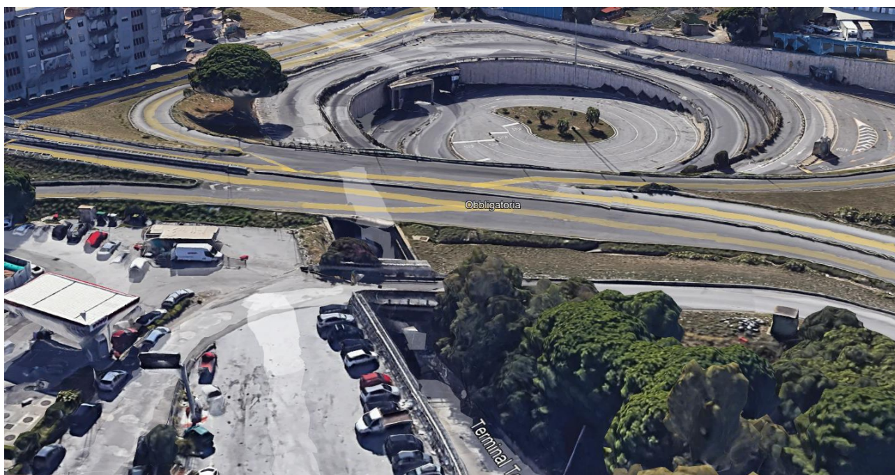
Figura 1-1 Approdo di Tremestieri – Attraversamento nel tratto terminale della rampa di uscita;
