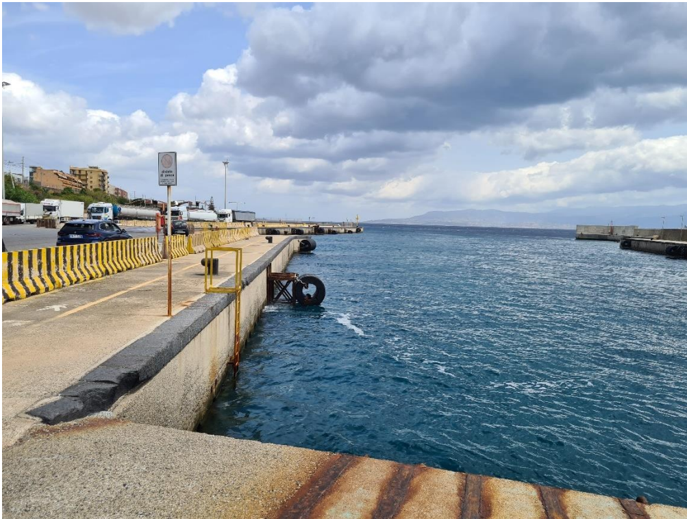
Figura 3-3 Muro di sponda
