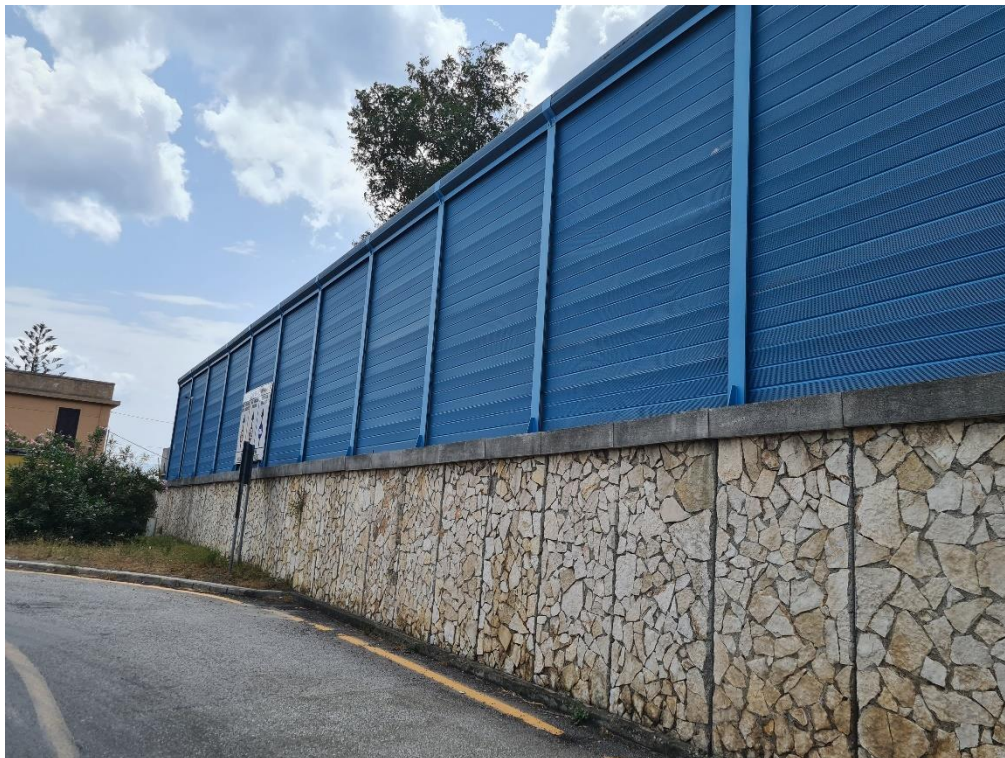
Figura 2-2 Muro in pietra locale sormontato da pannelli fonoassorbenti
