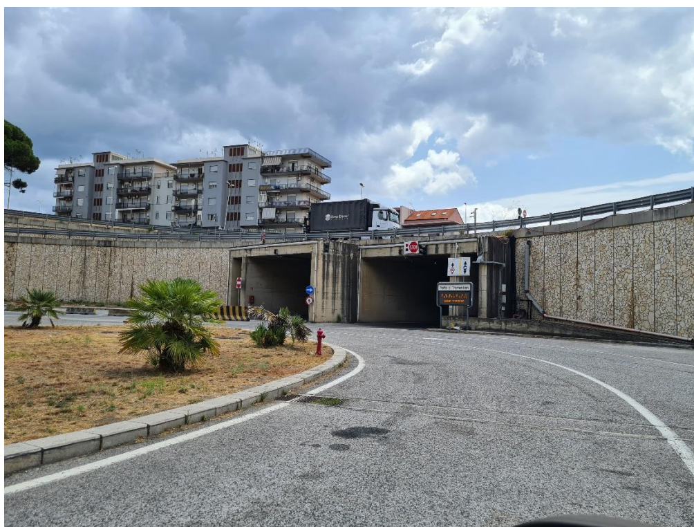
Figura 2-5 Scatolare in c.a. (lato zone a terra)
