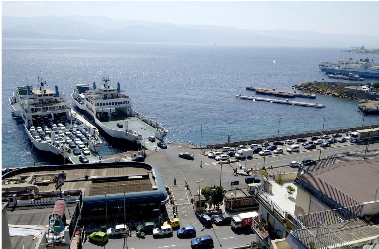
Approdi Caronte e, sulla destra, l'area cantieristica
