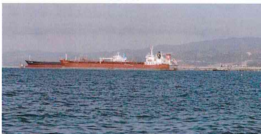
Panoramica della Raffineria
