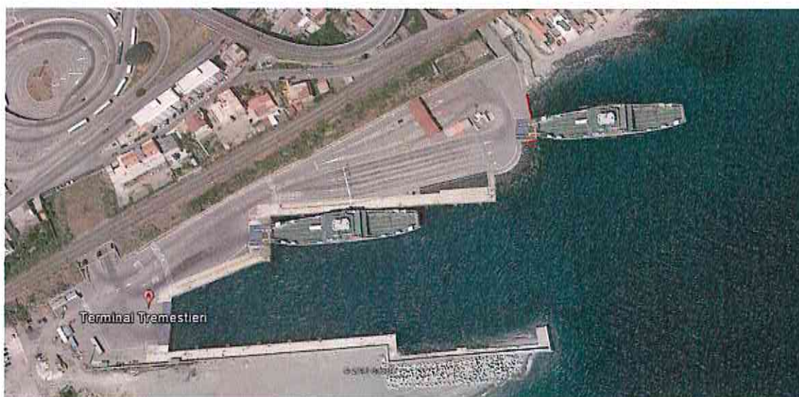
Panoramica del Porto di Tremestieri con un terzo scivolo operativo
