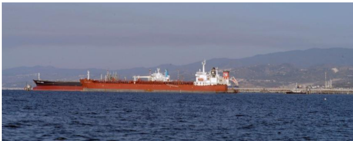
Panoramica della Raffineria
