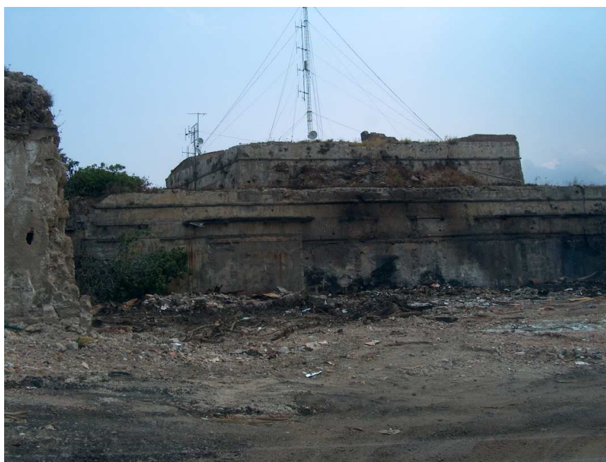
bastioni della fortezza "Real Cittadella" recentemente liberati da superfetazioni.
